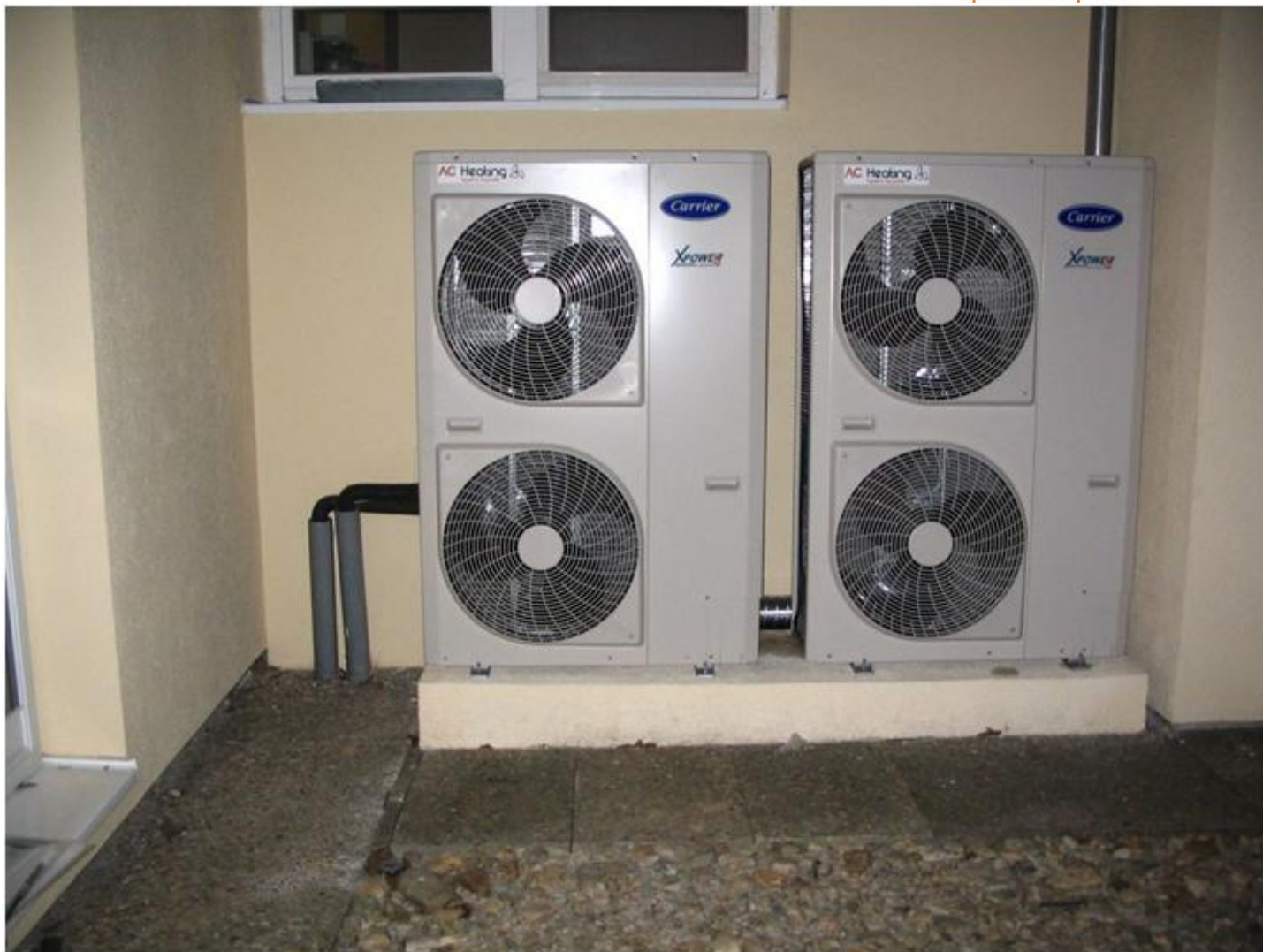
Venkovní jednotka po montáži 4
