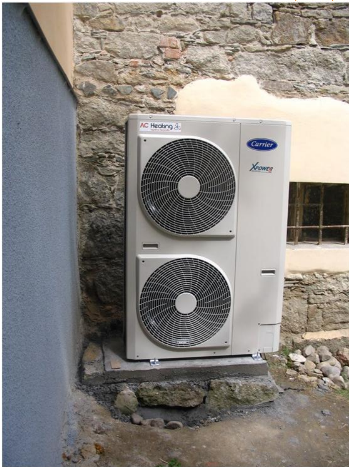
Venkovní jednotka po montáži 3
