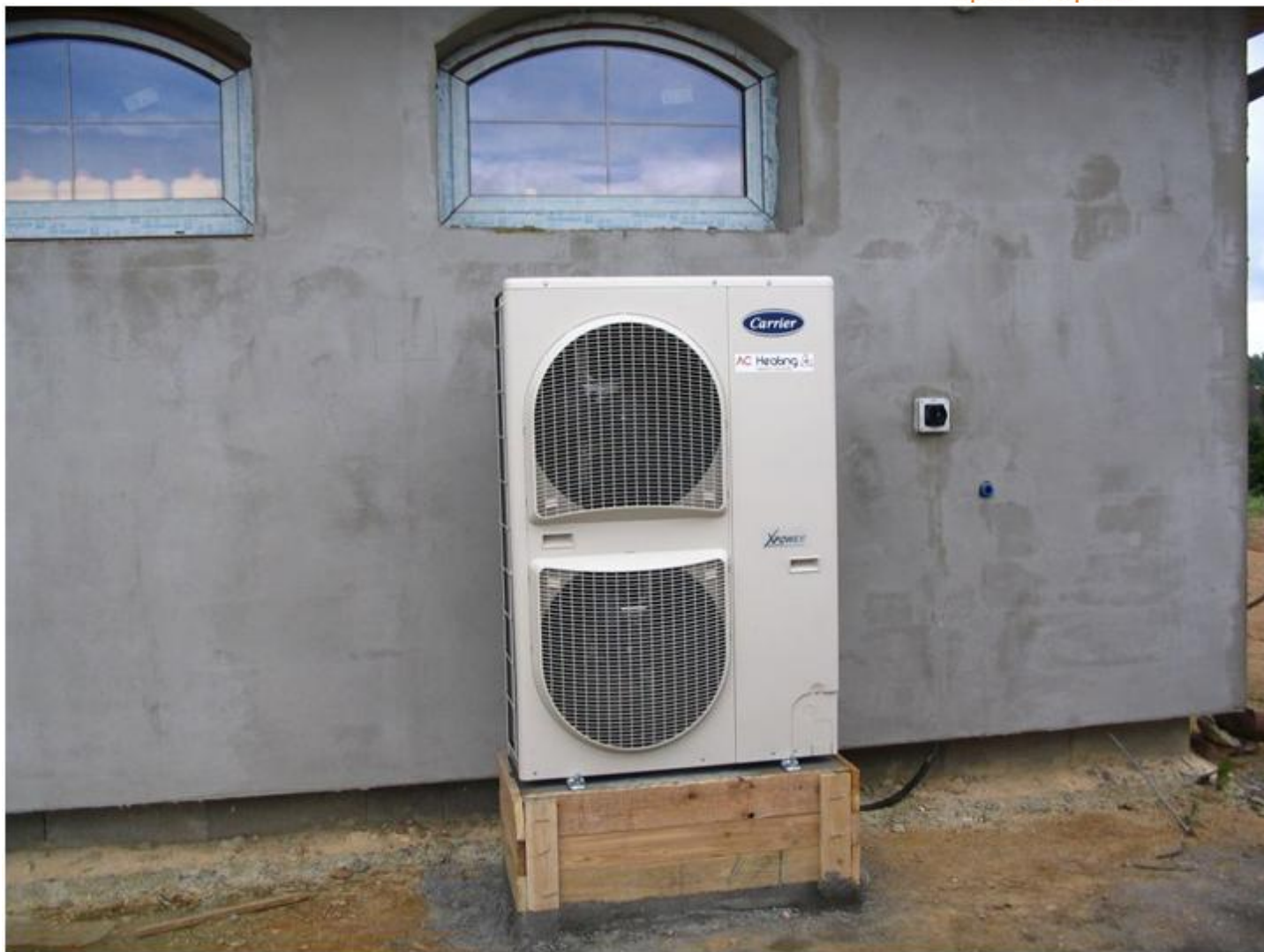
Venkovní jednotka po montáži 1
