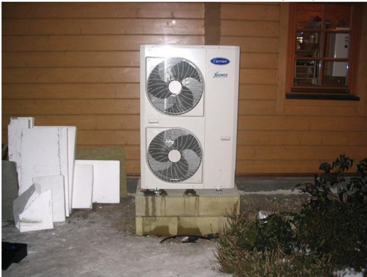
Venkovní jednotka po montáži 2
